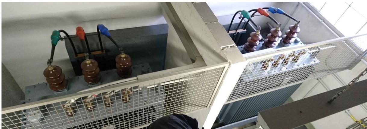
Im Inneren einer Transformatorstation könnte es dann so aussehen. Hier sind gleich zwei Transformatoren zu sehen. Gut zu erkennen ist die Primärseite mit den braunen Isolatoren.
